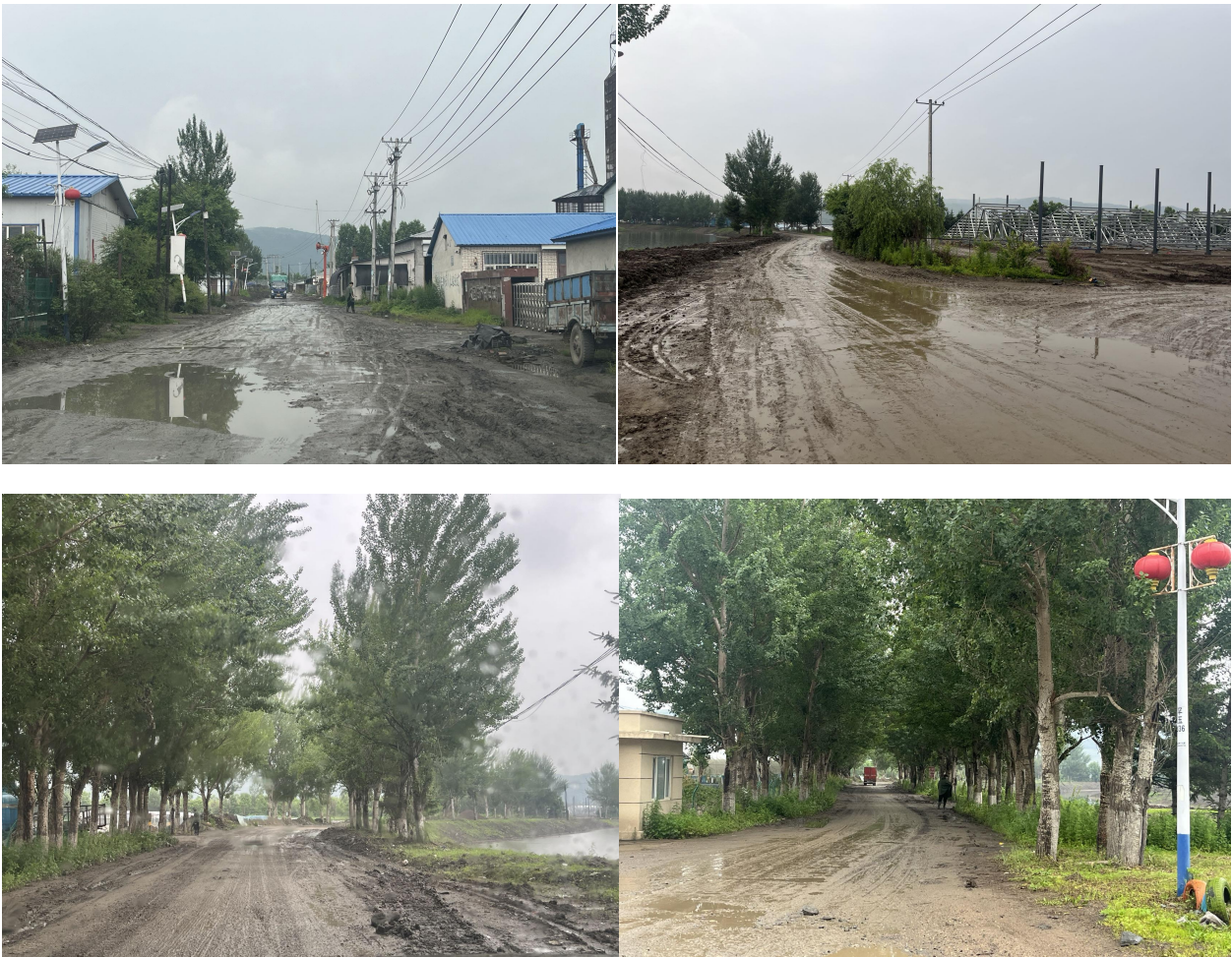
悬羊村道路 K0+000-K0+123 段旧路面为砂石路面，本次改造里程 0.123 公里。
