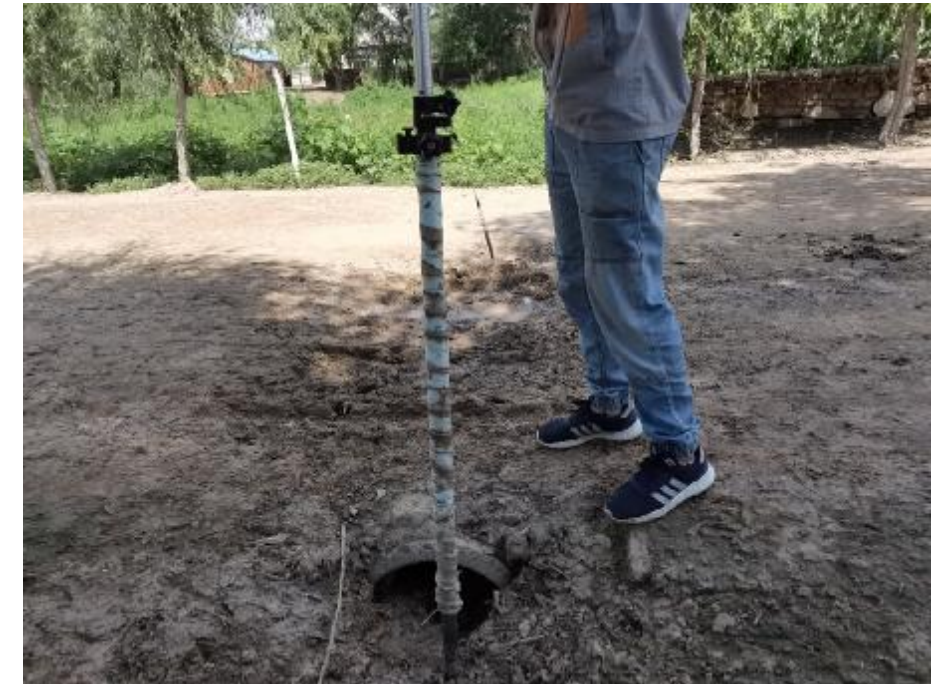
涵洞现状照片
