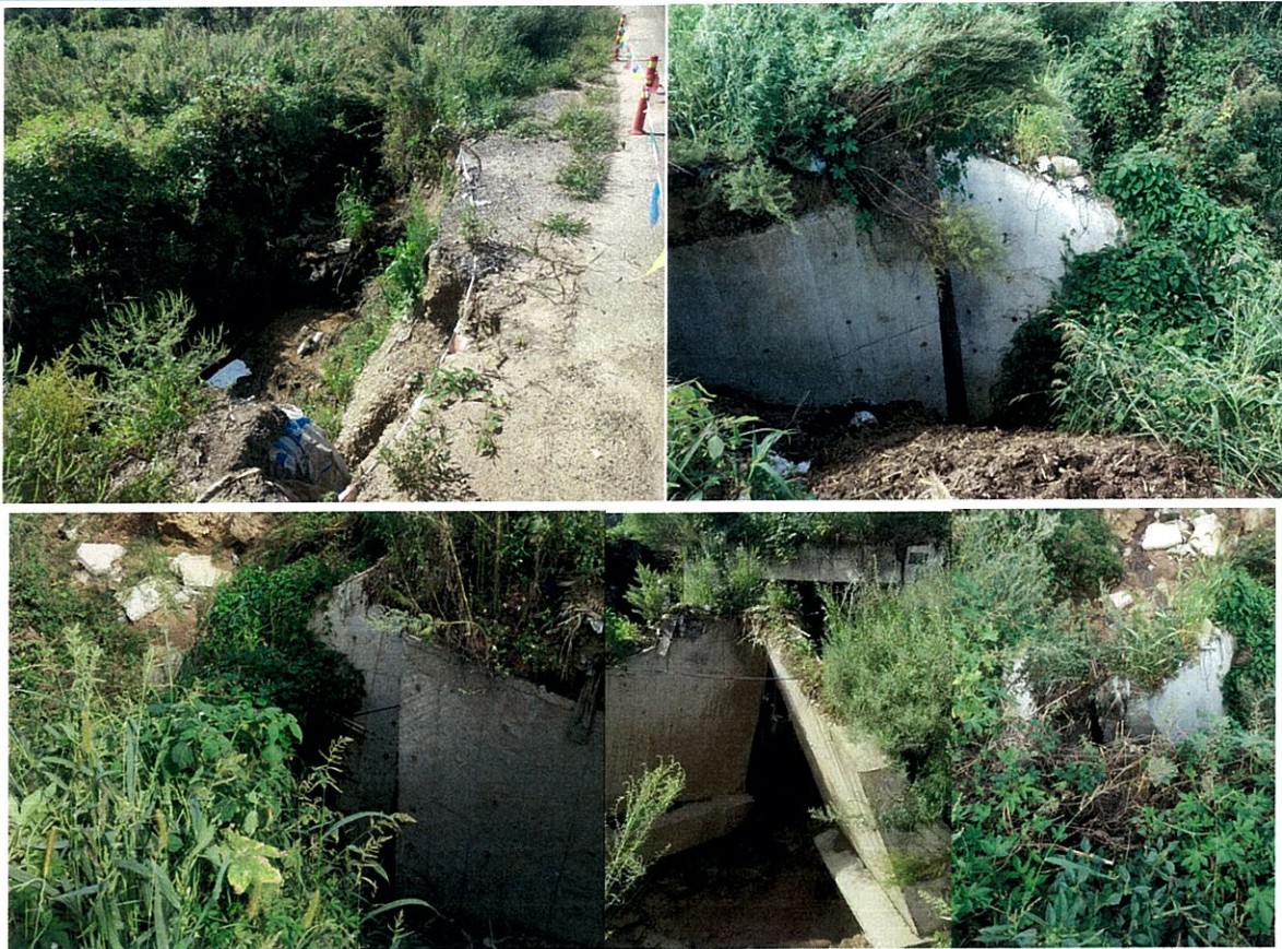
涵洞 5：哈达—麒麟山公路（X301230321），桩号 K36+620，1-0.8m 钢筋混凝土圆管涵，公路等级为三级，沥青混凝土路面，路面宽度 6.0 米，路基宽度 7.0 米，建成于 2014 年 10 月。改建为 3*1.6m 钢筋混凝土箱涵。
