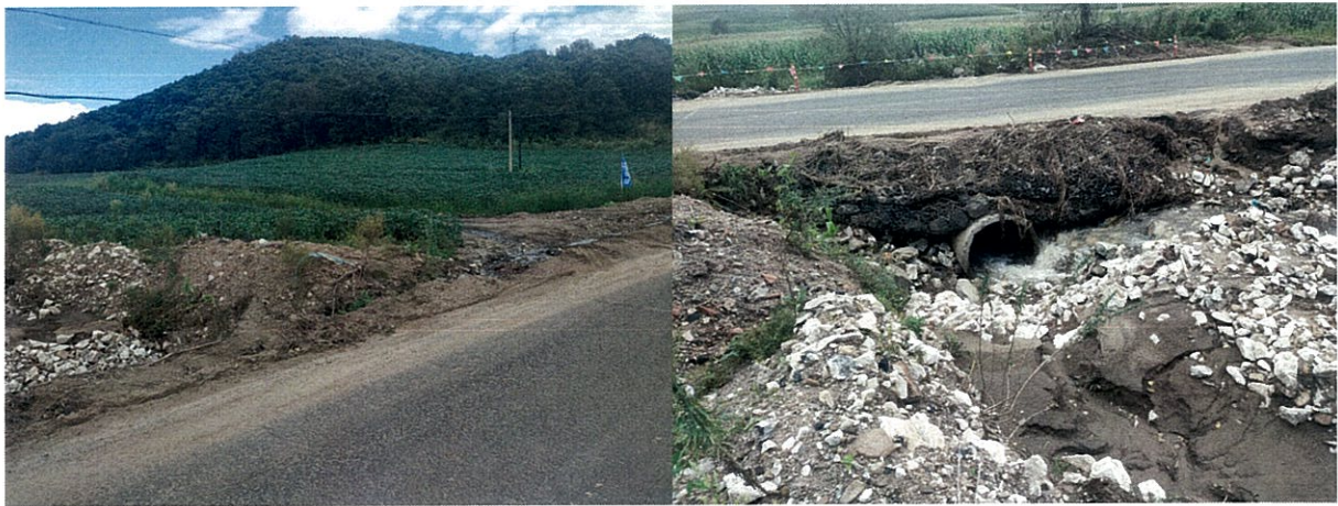
涵洞 5：哈达—麒麟山公路（X301230321），桩号 K36+620，1-0.8m 钢筋混凝土圆管涵，公路等级为三级，沥青混凝土路面，路面宽度 6.0 米，路基宽度 7.0 米，建成于 2014 年 10 月。改建为 3*1.6m 钢筋混凝土箱涵。
