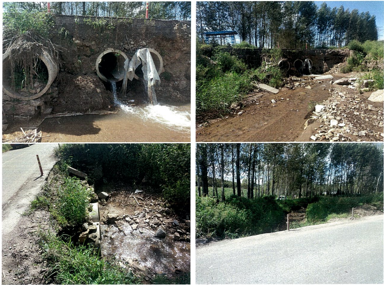
涵洞 4：哈达—麒麟山公路（X301230321），桩号 K26+082，钢筋混凝土箱涵，公路等级为三级，沥青混凝土路面，路面宽度 6.0 米，路基宽度 7.0 米，建成于 2014 年 10 月。重做防护。
