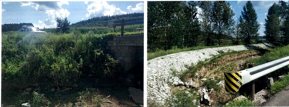
涵洞 3：哈达—麒麟山公路（X301230321），桩号 K12+122，3-1.0m 钢筋混凝土圆管涵，公路等级为三级，沥青混凝土路面，路面宽度 6.0 米，路基宽度 7.0 米，建成于 2014 年 10 月。改建为 3*2.0m 钢筋混凝土箱涵。
