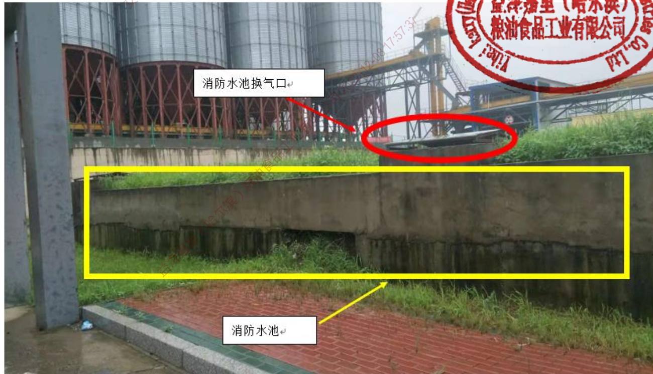
地下消防水池
